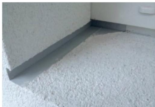
Figura 2.3) A sinistra: profilo per l'intonaco come preparazione per montaggio del davanzale con una seconda superficie impermeabile; a destra: fase successiva con davanzale in pietra infilato e montato. Da notare la fresatura sul bancale atto a raccogliere le acque piovane e favorirne il deflusso.
