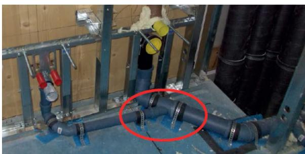
Figura 2.10) Corretto fissaggio della tubazione al solaio.
