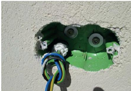
Figura 2.17: Sigillatura del passaggio esterno di un cavo.
