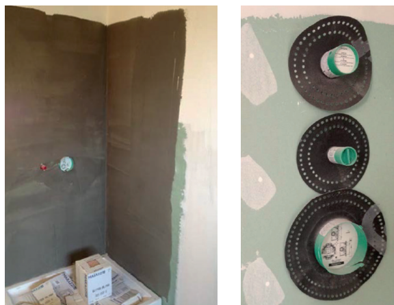
Figura 2.11 & 2.12) Impermeabilizzazione doccia.
