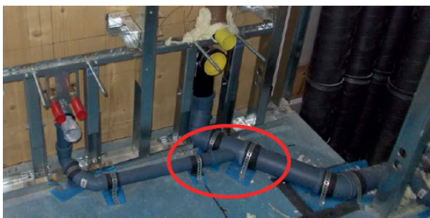
Figura 2.8) Assenza di protezione per la struttura in legno.
