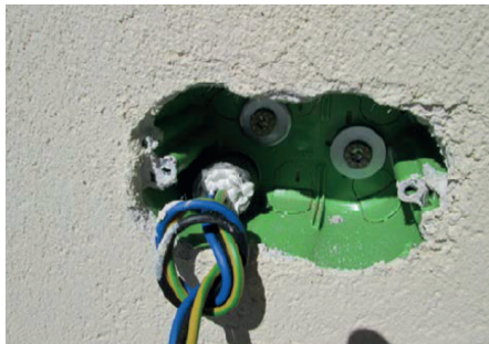
Figura 2.17: Sigillatura del passaggio esterno di un cavo.
