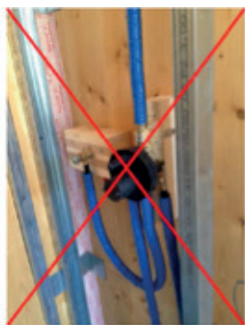
Figura 2.8) Assenza di protezione per la struttura in legno.
