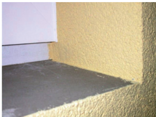
Figura 2.2) Seconda superficie impermeabile del parapetto portato finito (boiacche impermeabilizzanti incluso il rialzo laterale già intonacato).
