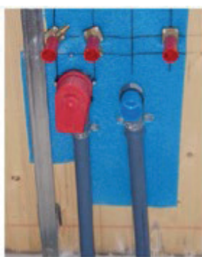
Figura 2.9) Presenza di protezione per la struttura in legno.
