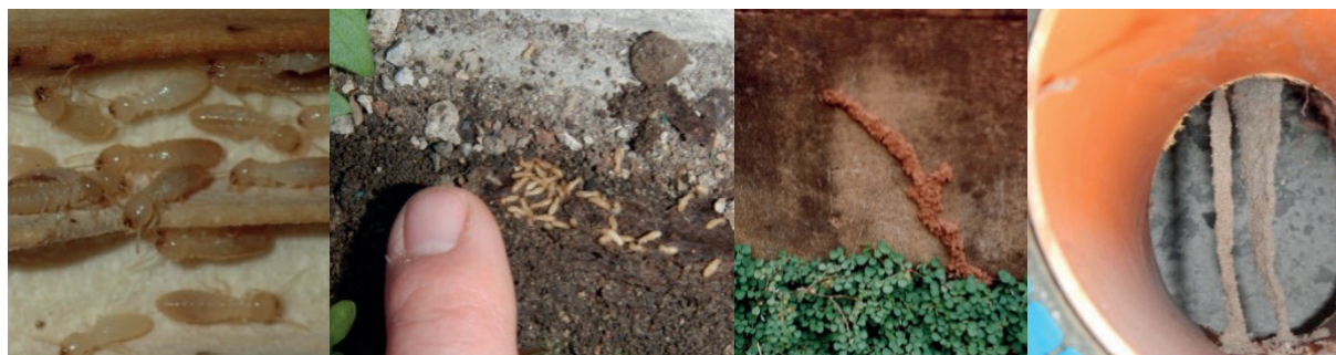
Figura 2.18: Prima e seconda foto: termiti; terza foto: galleria su di un muro; quarta foto: gallerie pendule in un canale di ventilazione.
